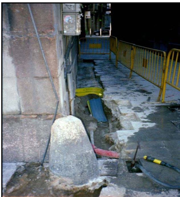
10. Finalització dels treballs a rasa 2 (UE 2000).
