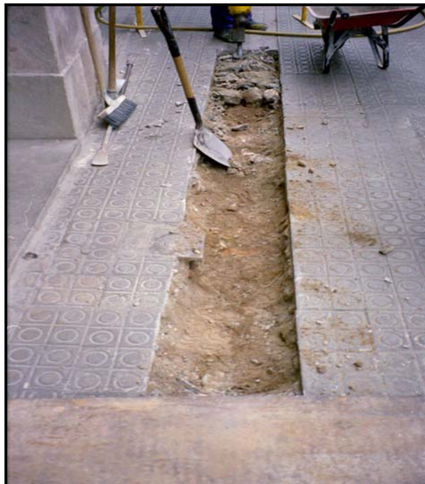
3. Inici de la rasa 1 (UE 1000).
